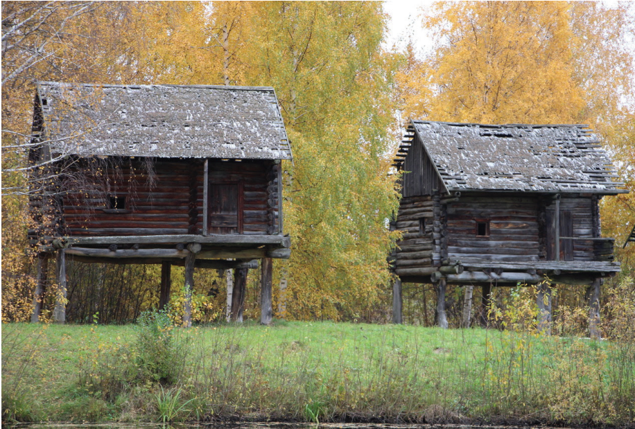
Kuva 1. Tammipaalujen päälle rakennetut, 1800-luvun jalkasaunat Kostroman alangon alueelta. Kaikkiaan saunoja on neljä, joista kuvan kaksi rakennusta näyttävät ulospäin parhaiten säilyneiltä. Saunat on sijoitettu Igúmenka-joen suvannon partaalle. Saunojen lähelle on ehdoton kulkukielto, joten kuva on otettu vastarannalta. Kostroma, 2018. (Kuvannut: A. Ahlqvist.)
