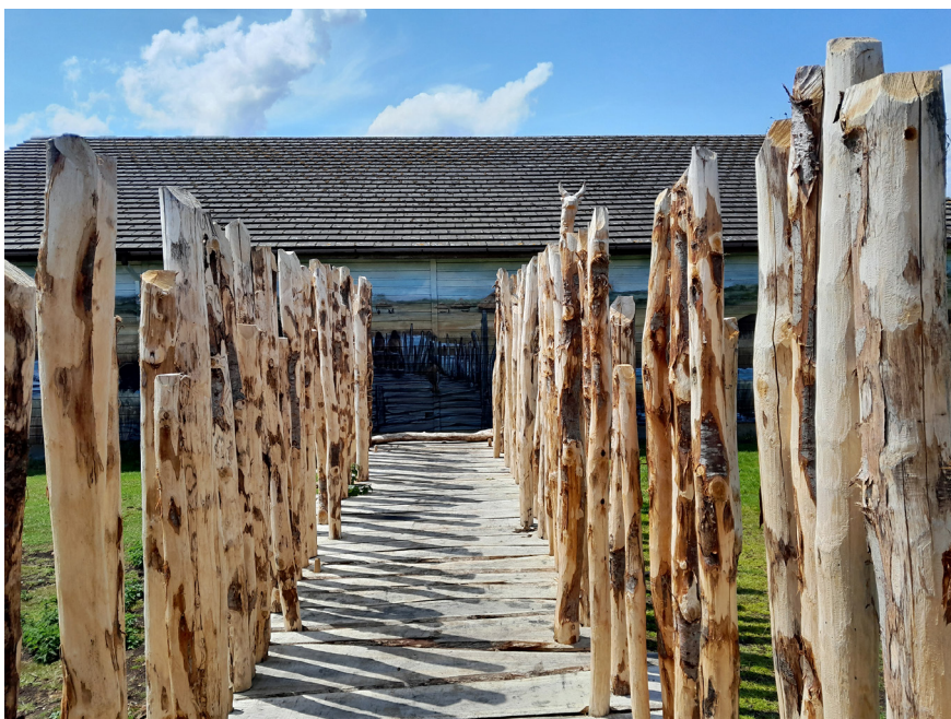
Kuva 3. Kävelysillan ennallistusta johtamassa päin seinää (kuva: Aleksi Kelloniemi).
