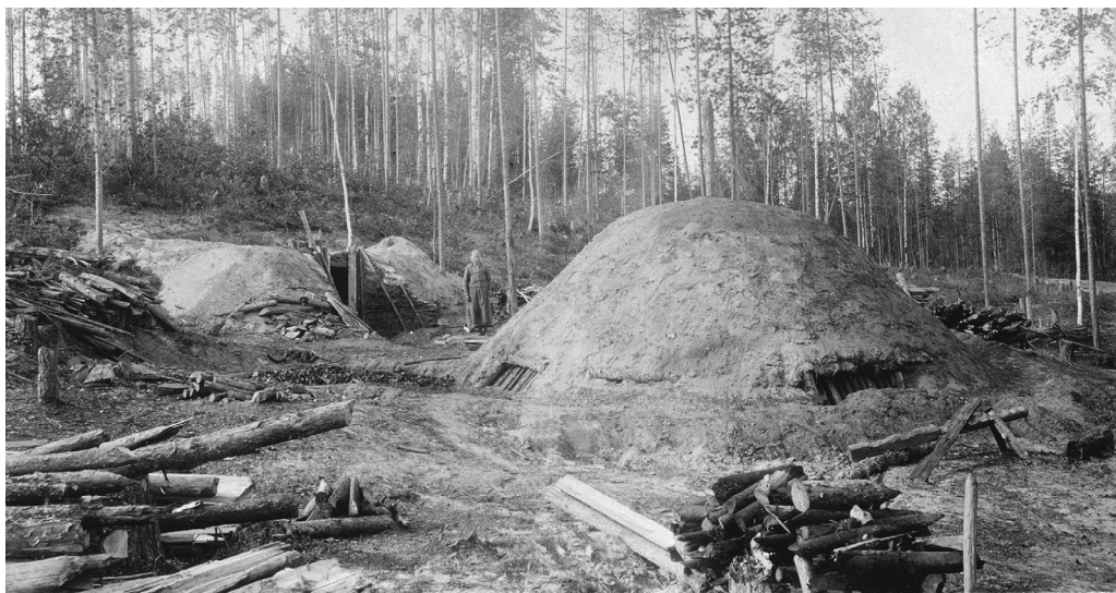
Kuva 1. Hiiltopuita, maahan osittain kaivettu uunillinen miilumaja eli miilusauna ja useammalla virityskuotilla varustettu pystymiilu tuulensuojaisella paikalla. (Kuva: U. T. Sirelius 1908, Museovirasto, Kansatieteen kuvakokoelma, KK985:33)
