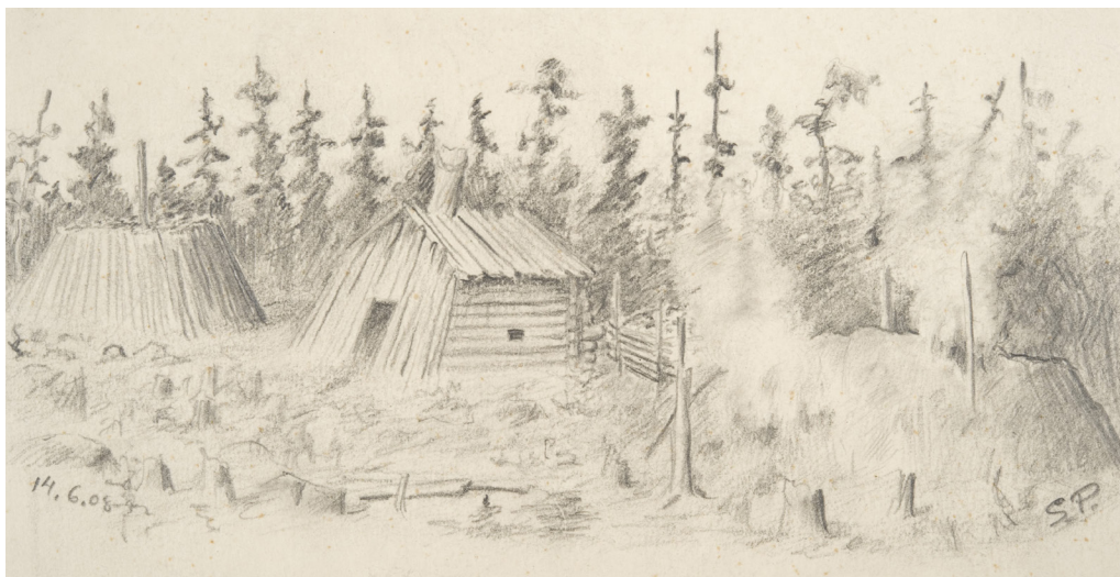
Kuva 2. Maan päälle rakennettu miilumaja ja Östgötatyyppisiä pystymiiluja, joista vasemmanpuoleinen on vielä peittämättä ja sytyttämättä. (Piirros: S. Paulaharju 1908, Museovirasto, Kansatieteen kuvakokoelma, KK1018:593)
