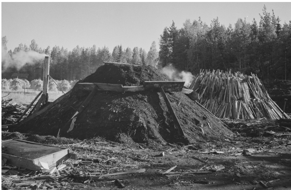
Kuva 4. Etualalla torvimiiilu savua tupruttavine torvineen ja sen oikealla puolella saksalaisen pystymiilun tapaan ladotut hiiltopuut ennen peittämistä. (Kuva: P. Kyytinen 1959, Museovirasto, Kansatieteen kuvakokoelma, Pekka Kyytisen kokoelma, KK5596:23.PO.8)
