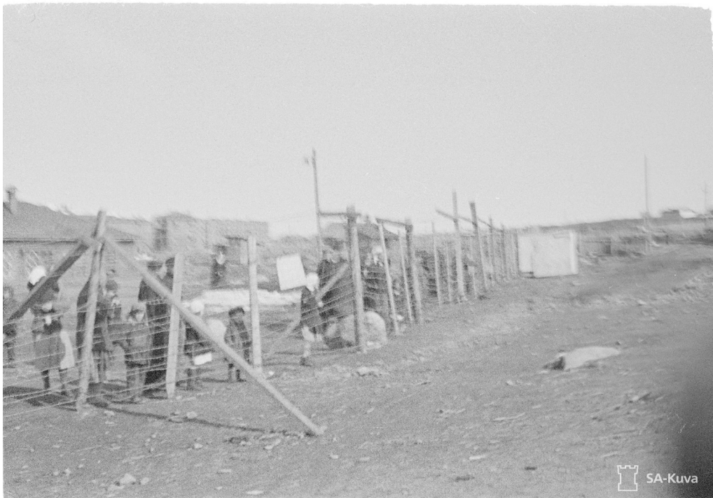
Kuva 2. Äänislinnan leiri toukokuussa 1942 (SA-kuva).
