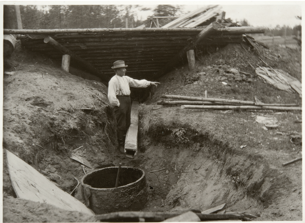
Kuva 6. Rännillinen suppilohauta, jossa on seinällisen komeron sijaan avoimempi rakenne. (Kuvannut: E. Aaltonen 1929, Museovirasto, kansatieteen kuvakokoelma.)
