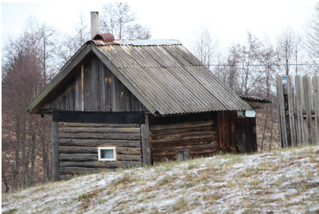
Kuva 6. Yksinäinen sauna Pášma-joen jyrkähköllä rinteellä. Saunan erikoisuutena ovat pystyhirsinurkat. Demnevon kylä, Iljinskojen piirikunta, Ivanovon alue, 2019 (kuvannut A. Ahlqvist).
